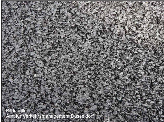
Beispiel Oberfläche lärmoptimierter Asphalt
