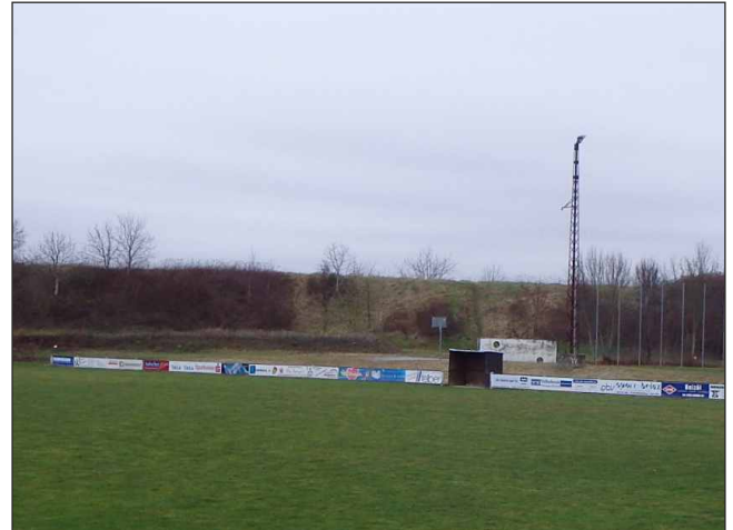
Lärmschutzwall entlang der A 5 bei Hartheim
