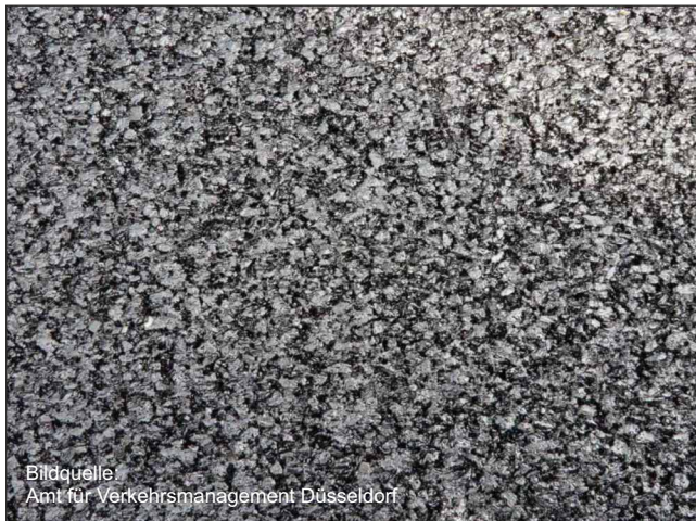
Beispiel Oberfläche lärmoptimierter Asphalt
